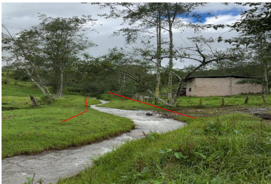
IMAGEN N° 02: VISTA DE TRAMO DE INICIO, PROGRESIVA 00+050, CON AMBOS MARGENES VULNERABLES DE LA QUEBRADA QUITAHUASI EXPUESTOS ANTE CRECIDA DE CAUDAL DE LA QUEBRADA, SE OBSERVA EL ANCHO QUE LLEGA EN EPOCAS DE
