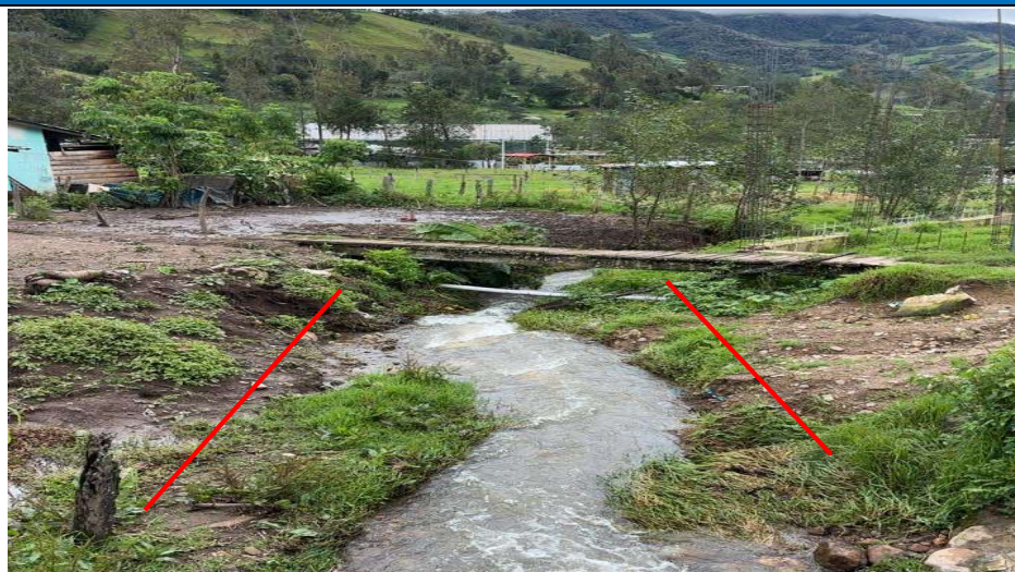
IMAGEN N° 01: VISTA DE TRAMO CON AMBOS MARGENES VULNERABLES DE LA QUEBRADA QUITAHUASI EXPUESTOS ANTE CRECIDA DE CAUDAL DE LA QUEBRADA, SE OBSERVA EROSION.
